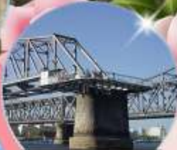
สะพานขาดตานตง
